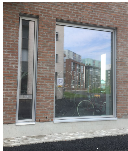
Ikkunallinen pyörävarasto katujulkisivussa. Kuva: Tampereen kaupunki (Riikka Rahkonen).
