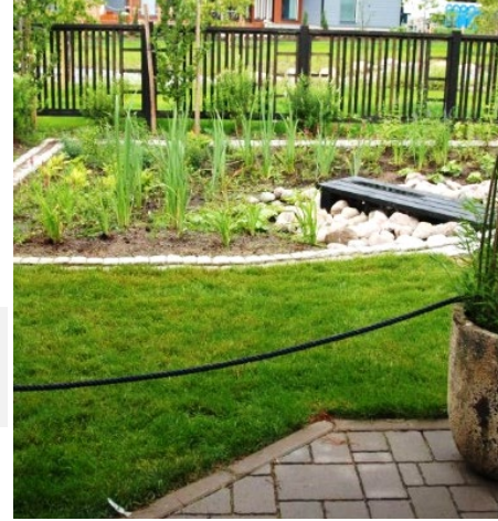
Hulevesien käsittelyalue sadeputarhassa. Kuva: Tampereen kaupunki.
